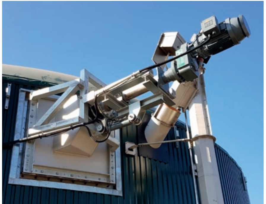
Außenständer-Wand-Konstruktion zum Einsatz in einem Stahlbehälter. Zur technischen Klärung ist vorab ein Fachgespräch notwendig.
