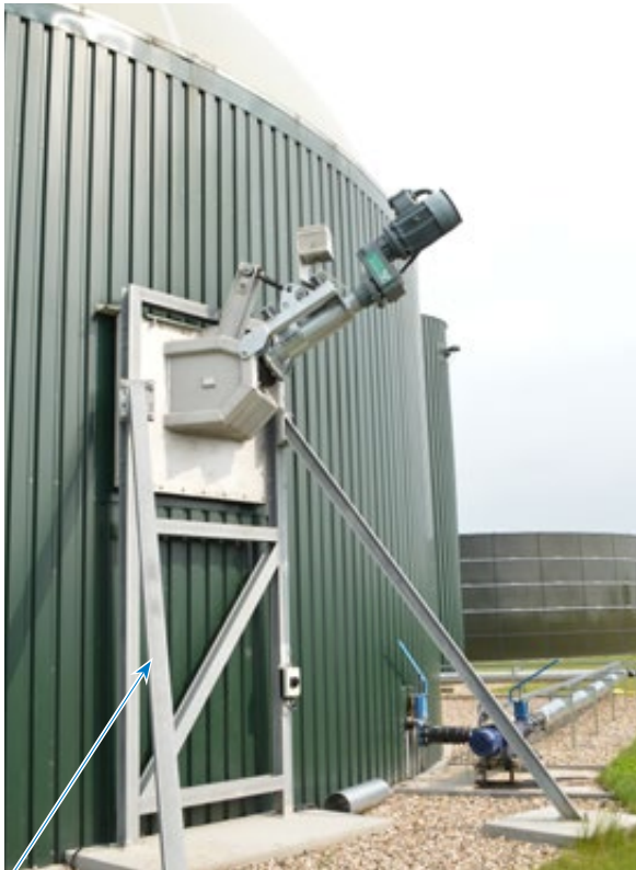
Construction de mur support extérieur pour l'utilisation dans un récipient en acier Pour la clarification technique, une consultation
