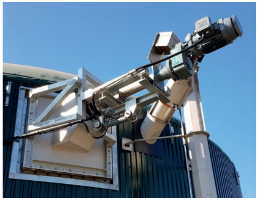
Buitenstaander wandconstructie voor de inzet in een stalen reservoir. Voor de technische uitleg is vooraf een vakgesprek noodzakelijk.
