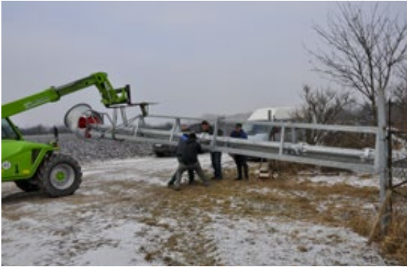
Montage ter plaatse
