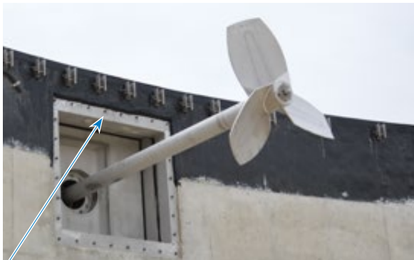
Beton bekisting voor de gemakkelijkere montage
